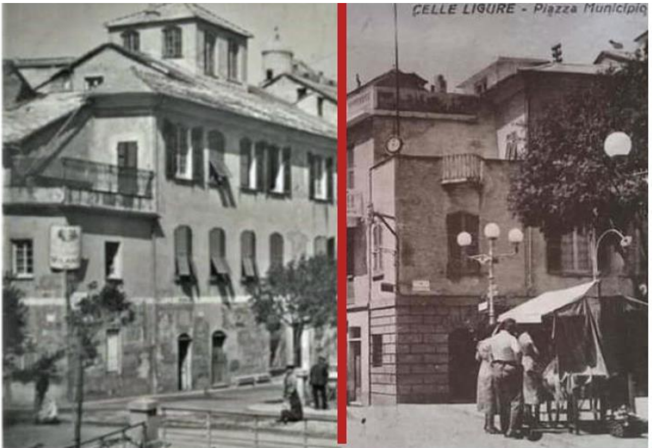
Immagine 3. Raffronto corpo a due piani lato sud: primi Novecento (a sin) e anni Cinquanta (a dx) Oltre all'ingrandimento degli infissi si notano, a dx: la presenza del basamento bugnato in pietra artificiale, la finestra al piano terra diventa una porta, cambia il parapetto del terrazzo e appare il balconcino
